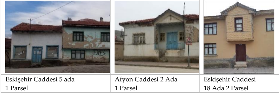
Şekil 17. Geleneksel konutların sokak cephelerinden örnekler
