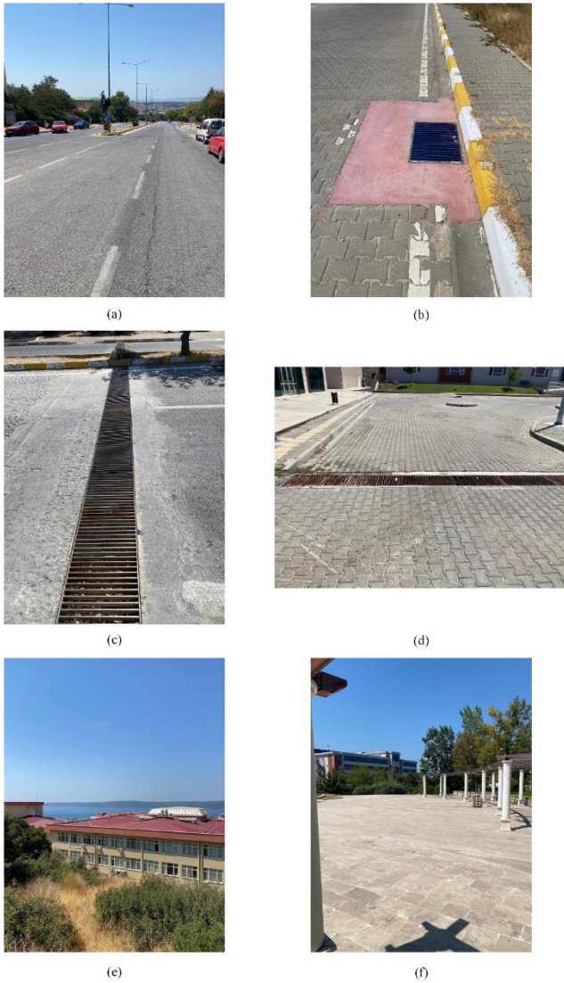
Şekil 4. Kampüs içerisinde yapılan gözlem sonucu mevcut durumlar (a) Asfalt uygulamaları, (b) Yol kenarı yağmur suyu altyapı sistemi, (c) Birleşim bölgesi yağmur suyu altyapı sistemi, (d) Düşük eğimde yağmur suyu altyapı sistemi, (e) Genel mevcut çatı düzeni, (f) Düşük eğimli geçirimsiz yüzeyler
