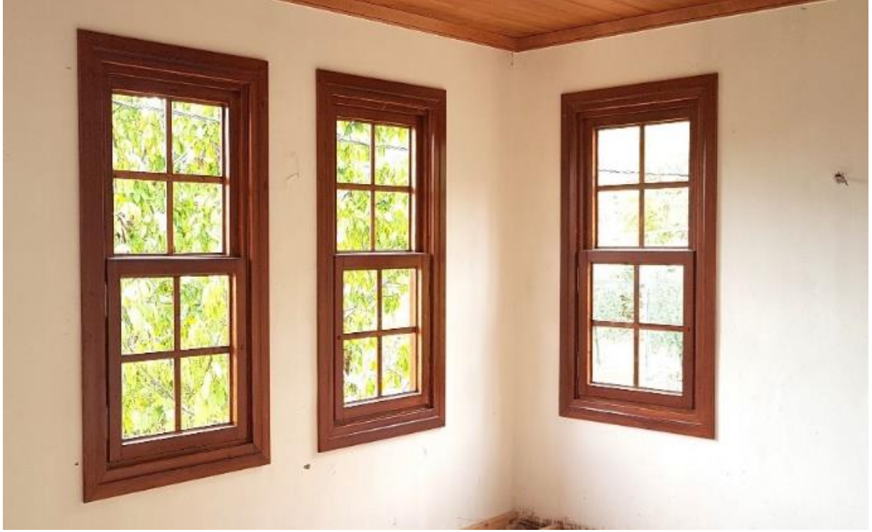
Şekil 13. Pencerelerin montajı, bire iki oranı ve giyotin görünümlü kanatlı
