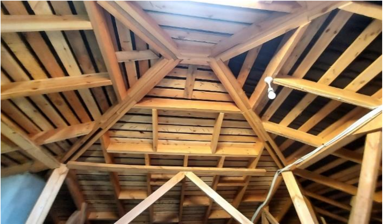
Şekil 10. İç taraftan çatı konstrüksiyonu
