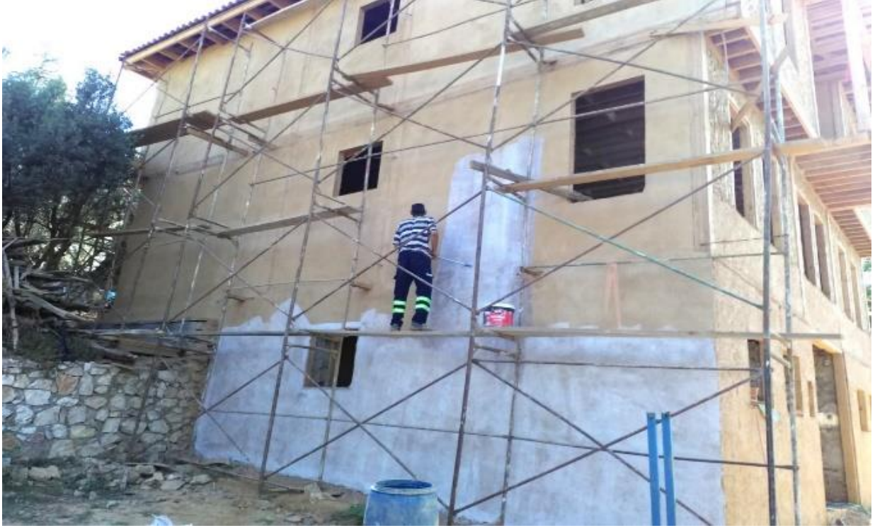
Şekil 15. Kireç badananın sürülme işlemi
