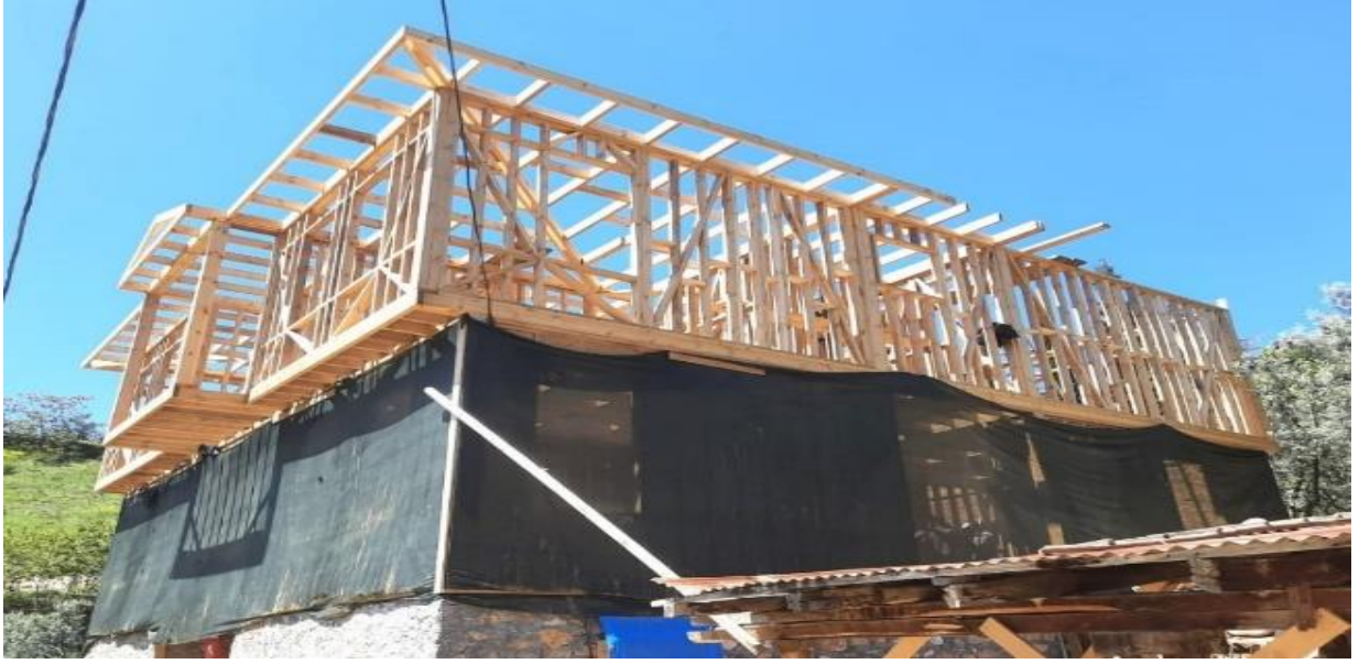
Şekil 7. Taş duvar, ahşap karkas
