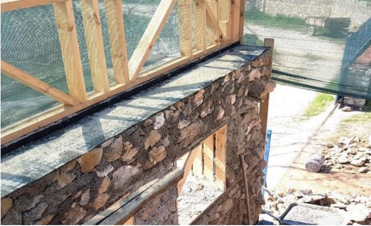
Şekil 6. Taş duvar ile ahşap duvar arasındaki ilişki
