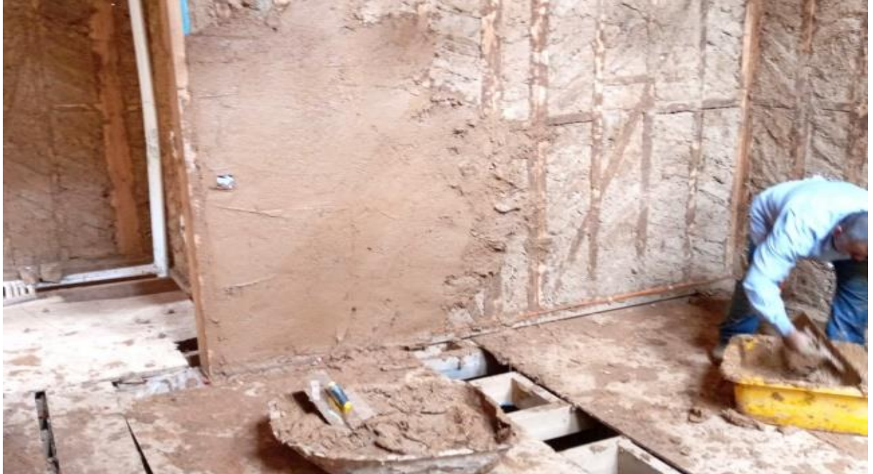
Şekil 12. Ahşap duvar üzeri kerpiç sıvanın kaba aşaması
