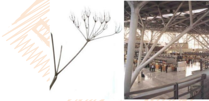
Şekil 1. Ağaç Benzeri Strüktür: Stuttgart Havaalanı Yolcu Terminali (Özdemir & Selçuk, 2016)
