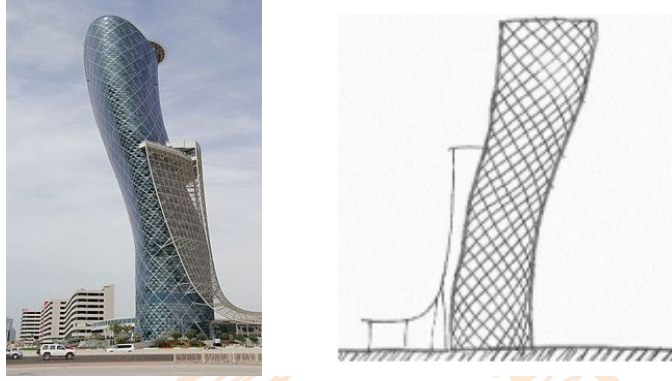
Şekil 6. Capital Gate Tower Cephesi (URL-4, 2022)
