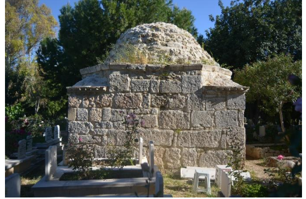
Fotoğraf 10 Anonim Türbe Doğu Cephe Görünüşü
