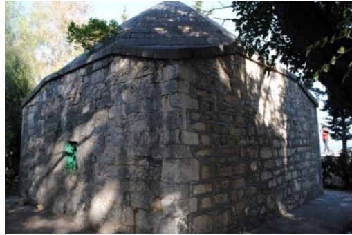
Fotoğraf 4: Sinan Paşa Kümbeti Kuzeybatı Köşeden Görünüş
