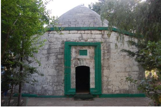
Fotoğraf 5: Sinan Paşa Kümbeti Doğu Cepheden Genel Görünüşü
