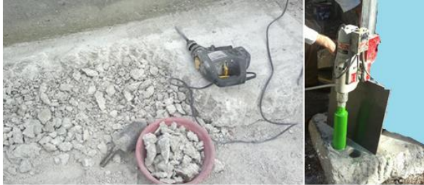
Şekil 1. Geri dönüşüm agrega elde edilmesi ve karot alınması (The process of producing recycled concrete aggregate and drilling core samples)
