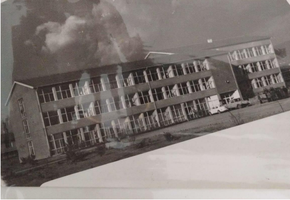
EK 3. Bolu Erkek Öğretmen Okulu’nun “Ankara Asfaltı” üzerine yapılan yeni binası.
