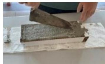
Şekil 7. Sıvaların gaz betonlara uygulanması
