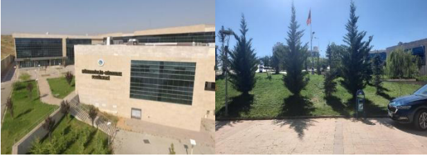
Şekil 10. Mühendislik-Mimarlık Fakültesi mevcut durumu [6] (orijinal)
