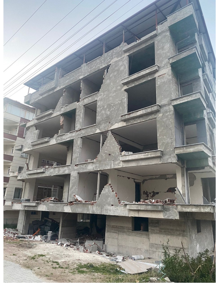
Şekil 3. Deprem Yönetmeliğine Uygun Yapılan İnşaat.
