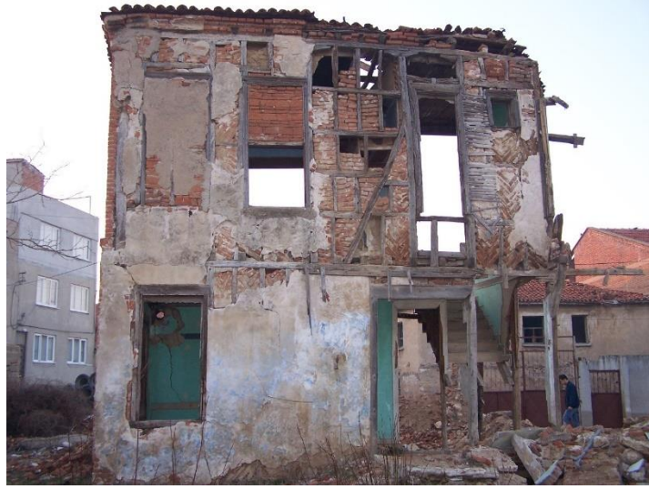
Şekil 6. Kırklareli Geleneksel Konutlarında Ahşap Malzemenin Taşıyıcı Olarak Kullanımı
