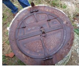
Bahçedeki bir su kuyusunun demir kapağı
