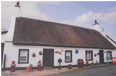
a. Taraklı saz çatı
