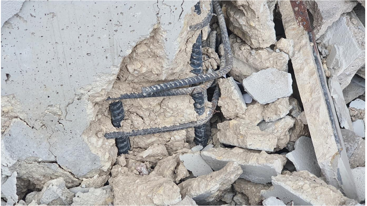
Şekil 6. Kolonda Uygun Olmayan Etriye Detayı
