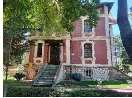
Kuzeydoğu (Giriş) Cephesi
