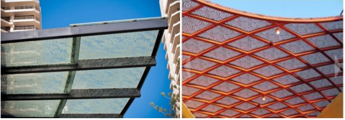
Görsel 12. (a) Cam tavan bina yağmurluk Koruma Paneli Uygulaması. (b) Cam tavan uygulaması, Chinatown Alışveriş Merkezi ( http://www.diptech.com.tr )
