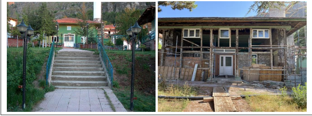
Görsel 14: Restorasyon öncesi ve restorasyon sırasında kuzey cephe
