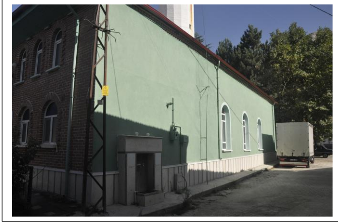
Görsel 23: Caminin batı cephesi
