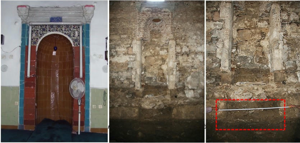
Görsel 20: Mihrabın restorasyon öncesi ve restorasyon esnasındaki genel görünümü ile Mihrabın altında tespit edilen niş
