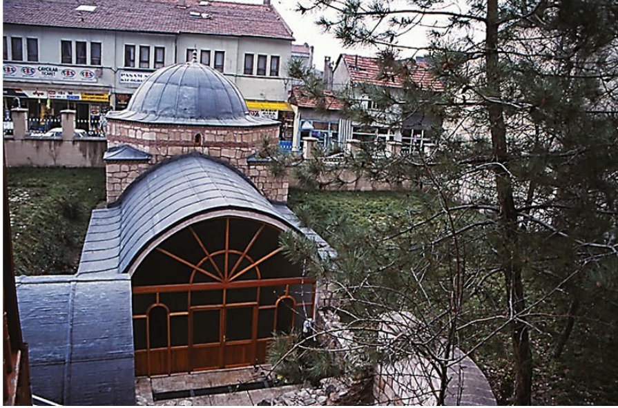
Görsel 25: Paşam Sultan Türbesi genel görünüm
