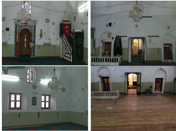
Görsel 3: Kurşunlu Caminin onarım öncesi içten genel görünümleri
