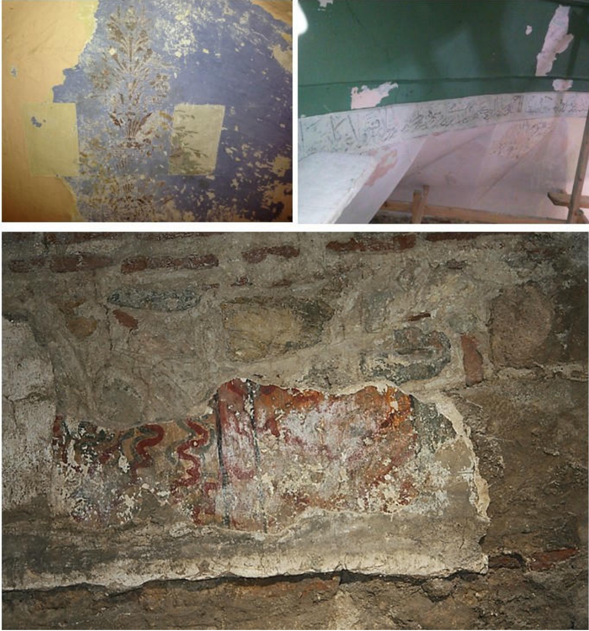
Görsel 23: Yapının kubbe kasnağı ve geçişleri ile duvarlarda tespit edilen kalem işi süslemeler
