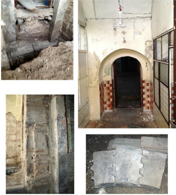
Görsel 9: Giriş kapısının restorasyon öncesi görünümü ve restorasyon çalışmalarında bulunan kemer taşları ile sü-tunce boşluğu
