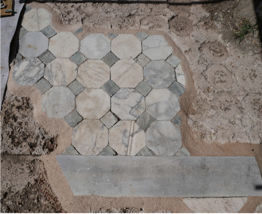
Resim 12 Kenarların harç ile sağlamlaştırılması.
