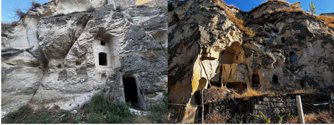
Şekil 13. Cemil Köyündeki Kaya Oyma Yapılar
