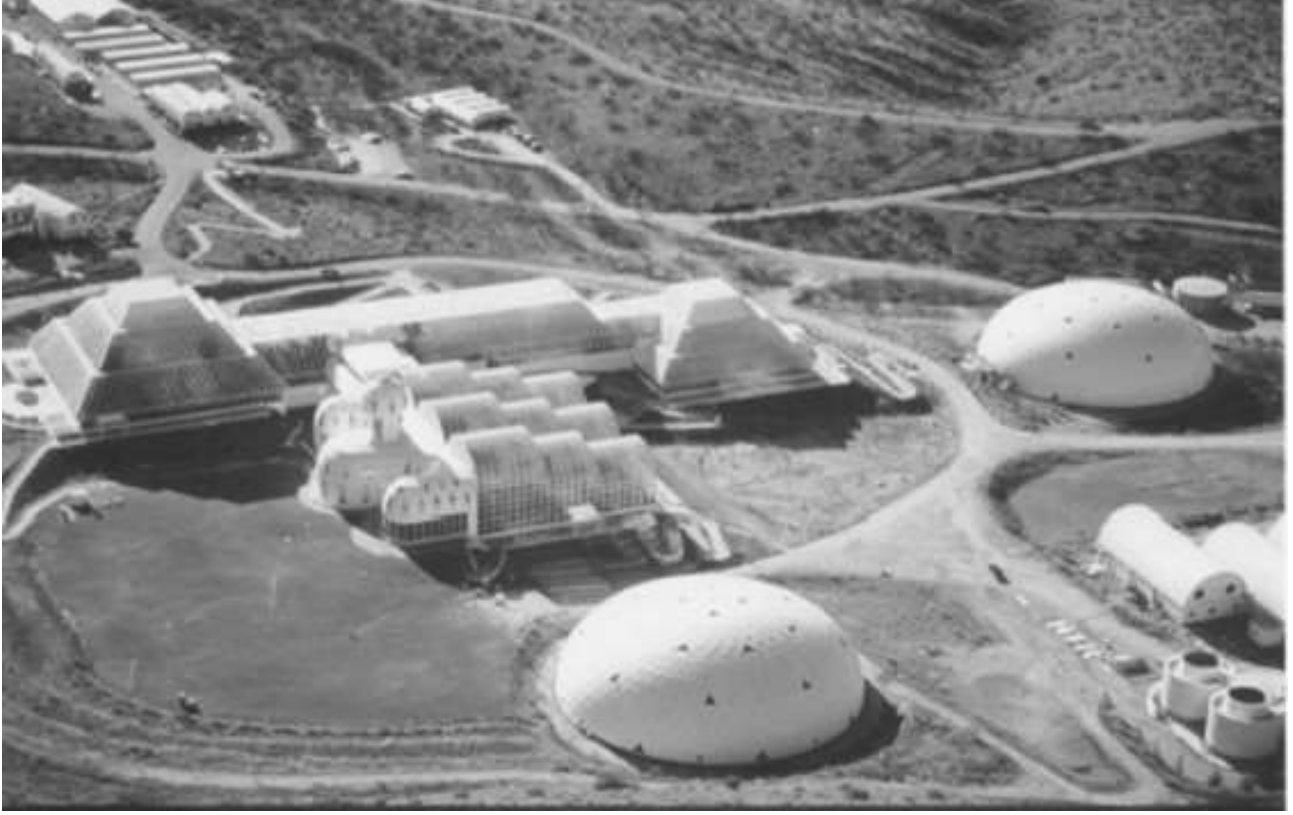
Şekil 1. Biyosfer-2'nin Gill C. Kenny tarafından çekilen kuşbakışı fotoğrafı. Cam uzay çerçevesinin üst bölümünde yağmur ormanı, savana, okyanus, bataklık, çöl; sağ ortada beşik tonozlu yapıda tarım ve insan yaşam alanı; sağ alt tarafta dış enerji merkezi; fotoğrafın üst kısmında araştırma ve geliştirme kompleksi yer almakta, beyaz kubbeler iki değişken hacimli “akciğer” olarak nitelendirilmektedir.
