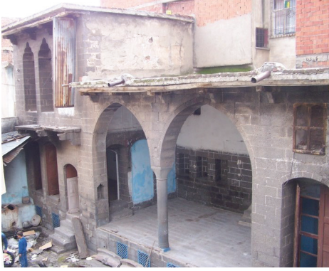
Şekil 5.Yapının restorasyon öncesi güney cephesi
