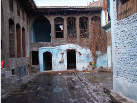
Şekil 6.Yapının restorasyon öncesi batı cephesi
