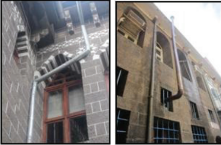
Resim 15-16. Yağmur borusu ve soba bacası ile uyumsuz görüntü ve fonksiyonların olduğu geleneksel ev örnekleri
