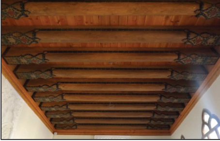
Resim 10. Geleneksel evlerde bezemeli ahşap kirişlemeli tavan
