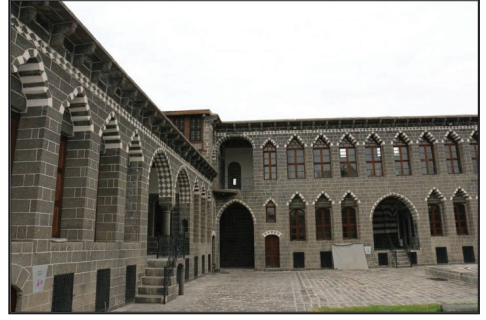
Resim 5. Cemil Paşa Konağı harem bölümü avlu cephesi
