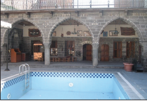
Resim 19. Özgün havuzu yıkılarak yerine yüzme havuzu yapılmış ve otel olarak işlevlendirilmiş bir geleneksel ev.
