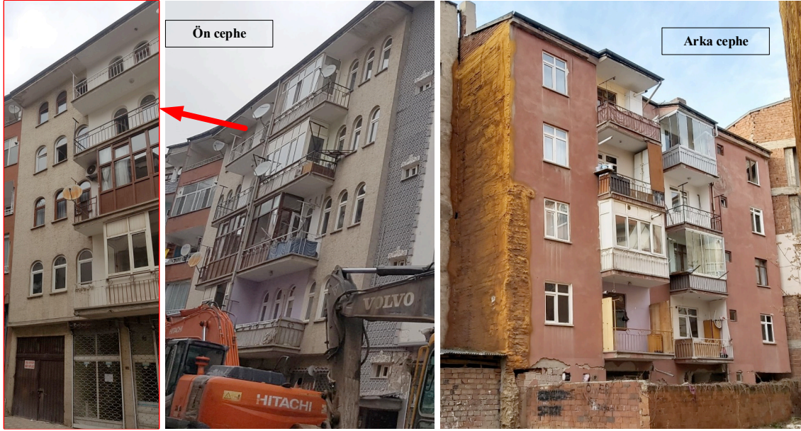
Şekil 5. Aydın apartmanı cephe görüntüleri.
