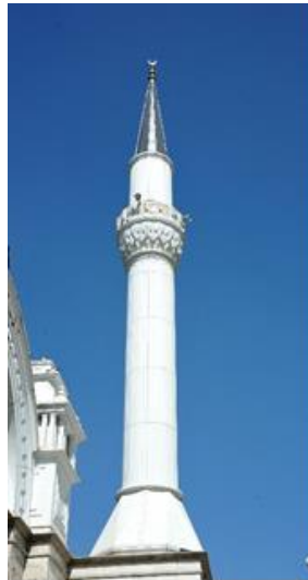
Res. 3: Kuzey Ankara Niyaziye Camii Minaresi Genel Görünüm
