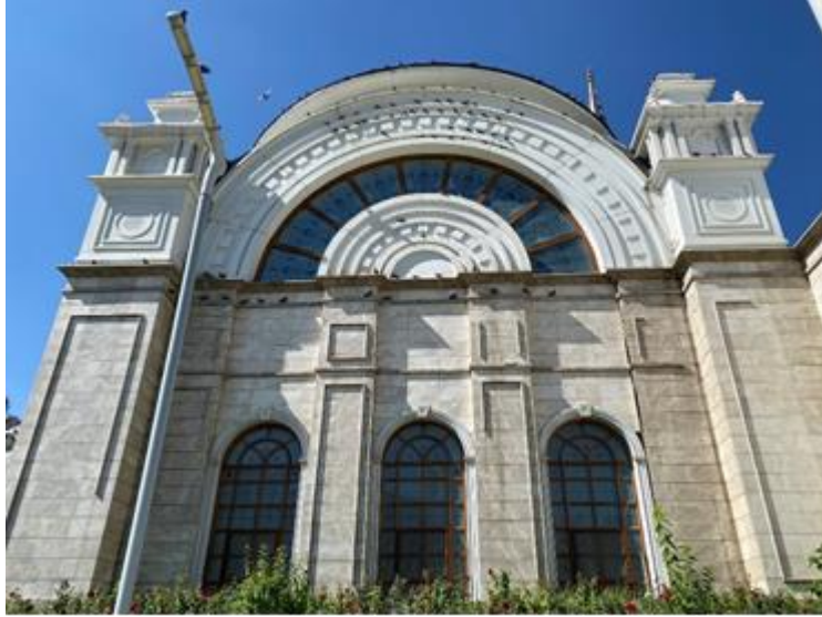
Res. 4: Doğu Cephe Genel Görünüm
