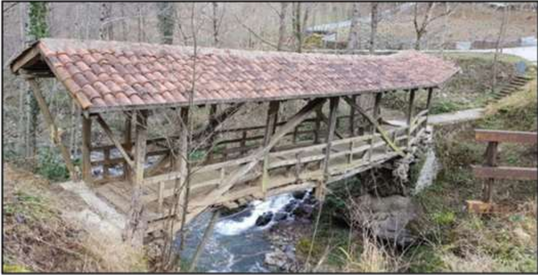
Şekil 13: Ahşap köprülerde görülen semer çatı; Eğridere Kiremitli Köprüsü, Trabzon-Çaykara-Buzlupınar köyü (Yazarın Arşivi)
