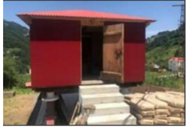
Şekil 19a (solda): Yerel olmayan bir malzemeyle zemine sabit biçimde inşa edilen merdiven; Trabzon-Tonya-İskenderli Mahallesi (Yazarın Arşivi)
