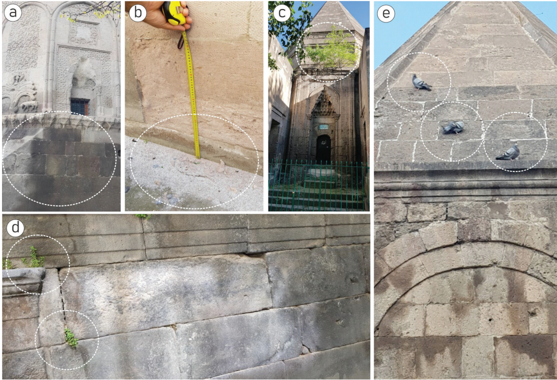
Şekil 8. İncelenen tarihi eserlerde gözlenen bazı kimyasal ve biyolojik bozunma izleri, a) kararma, b) tozlaşma, c-d) derz aralarında bitki büyümeleri, e) biyolojik birikimler.
