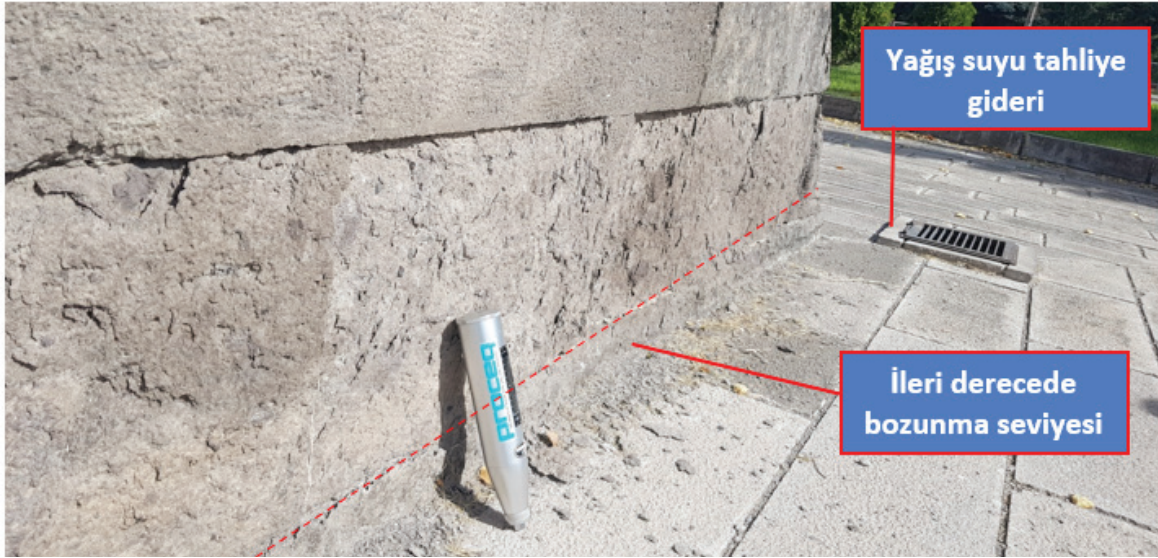
Şekil 11. Döner Kumbet çevresinde hatalı yapılan su giderleri sonucu kümbet tabanındaki bloklarda gelişen ileri derecede bozunma.
