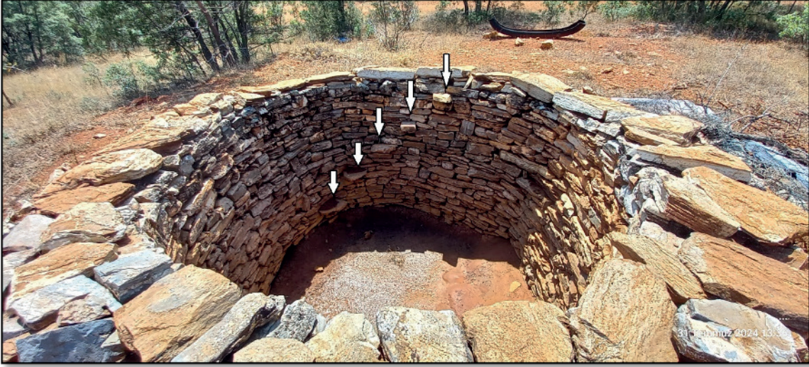
Fotoğraf 3: Avganların temizlik ve bakımında kullanmak için duvarda çıkıntı şeklinde bırakılmış taş basamaklar
