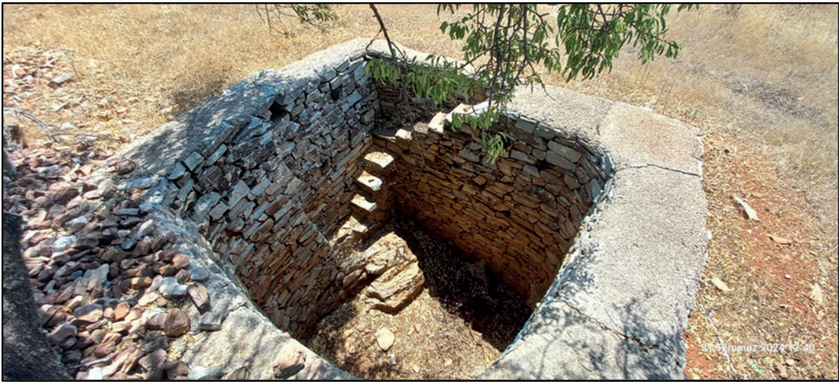
Fotoğraf 4: Dumanlı-Paşalar köyü arasında temelde sert kayacın çıkması nedeniyle derinliği az (3m), merdivenli ve susuz bir bülke (yüksekti 1016 m)
