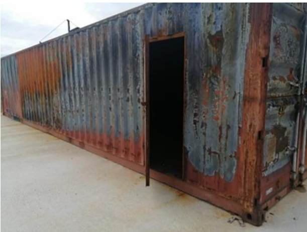
Şekil 12 : Yan yüzeyde yapılan kapının görünümü
