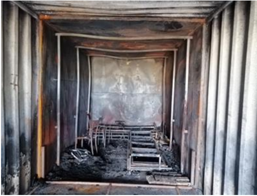
Şekil 9 : Konteyner içerisinde güçlendirilmiş yakma kısmı
