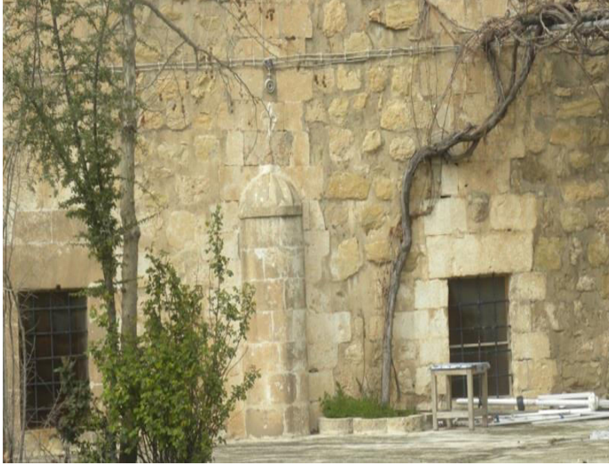
Şekil 15.Hamza-i Sağır Mescidi - Güney Cephe ve Mihrap
