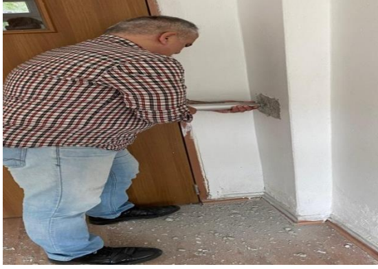
Şekil 3. Beton test çekici ile ölçüm yapılması
