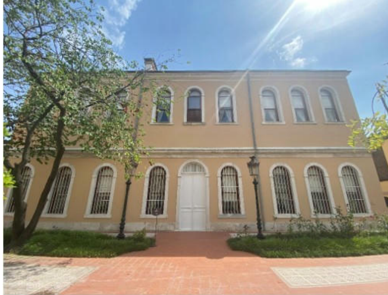
Görsel 4: Sonradan iki katlı olarak değiştirilip Harem yapısı olarak kullanılan binanın günümüzdeki görünüşü.
