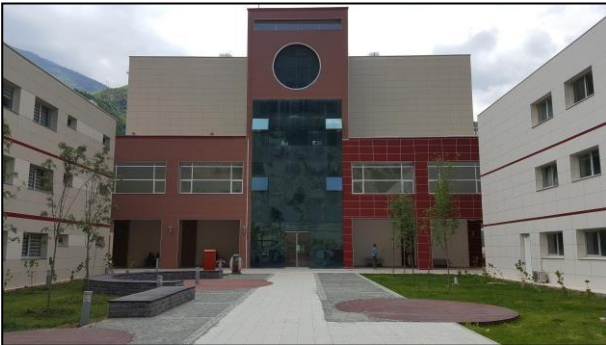
Şekil 3. Bina cephelerinde yer alan tasarım çizgilerinin sert zeminlerde yansıtıldığı bir örnek
