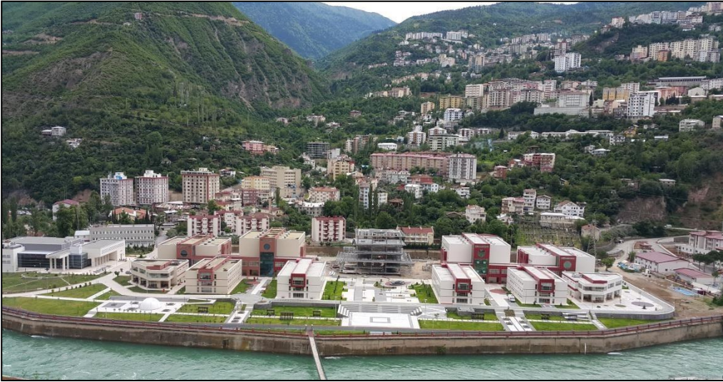
Şekil 5. Uygulanması gerçekleştirilen Şehir Yerleşkesinden bir görüntü
