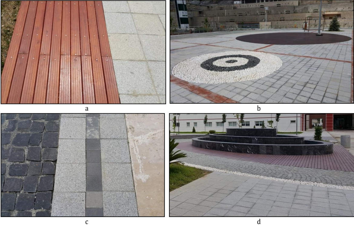
Şekil 20. Proje alanında kullanılan bazı döşeme malzemeleri (a- Ahşap deck, sulu kesim granit, b- Tuğla döşeme, sulu kesim granit, dolomit, ahşap deck, c- Doğal kesim bazalt küp taş, sulu kesim granit plak taş, patinotolu granit plak taş, traverten, d- Sulu kesim granit, dolomit, doğal kesim granit küp taş, ahşap deck)
