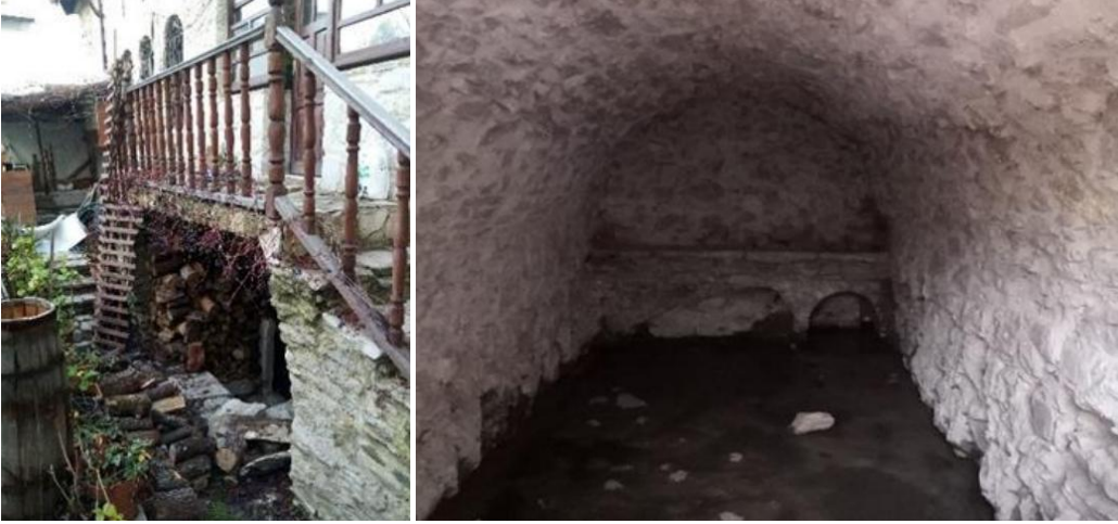
Resim 6a-b. Safranbolu, Kıranköy, Muhsin Bey Konağı'nın altındaki sarnıç (Yağcı ve Değirmenciler, 2023: 4186-4187)
