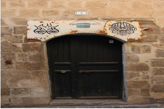
Resim 11: Kurtuluş Mahallesi 1040 Sokak No.3 ev giriş kapısı
