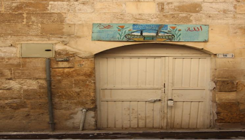
Resim 9: Ellisekiz Meydanı No.18 ev giriş kapısı
