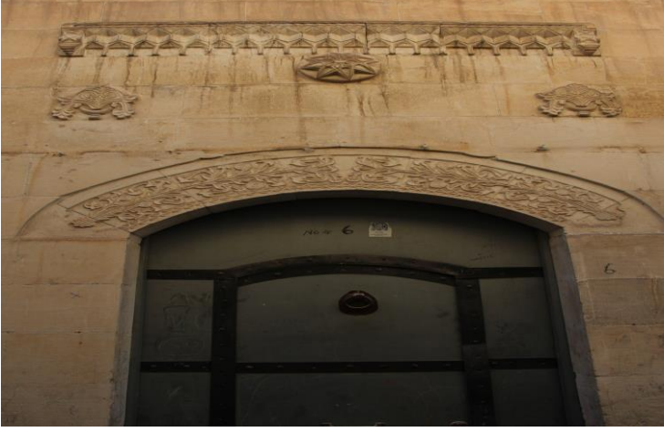
Resim 1: Kurtuluş Mahallesi Bardakçı Sokak No.6 ev giriş kapısı
