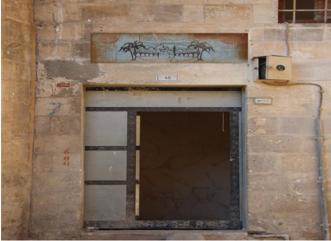
Resim 12: Ellisekiz Meydanı No.48 ev giriş kapısı
