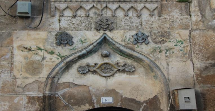
Resim 3: Kurtuluş Mahallesi 1011 sokak no.8 ev giriş kapısı
