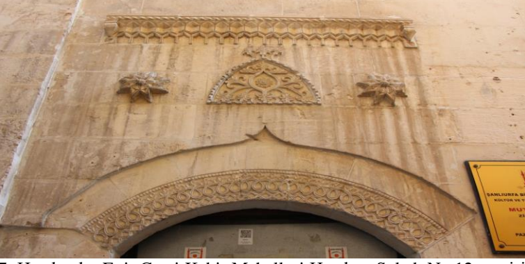
Resim 7: Hacıbanlar Evi- Cami Kebir Mahallesi Hacıban Sokak No.12 ev giriş kapısı
