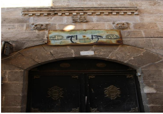
Resim 5: Kurtuluş Mahallesi 1025 Sokak No.28 ev giriş kapısı
