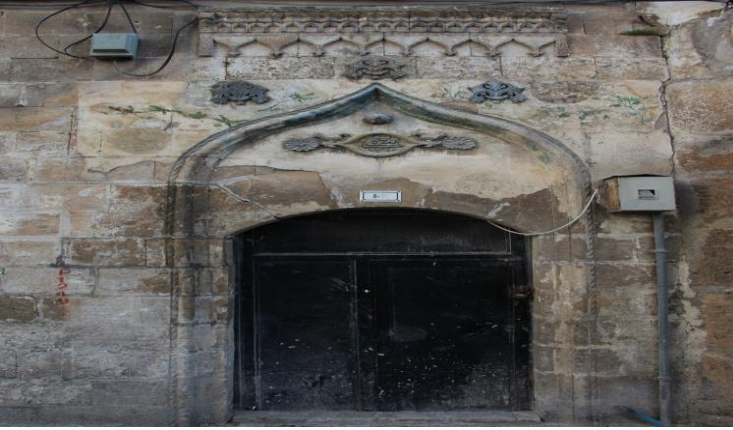
Resim 2: Kurtuluş Mahallesi 1011 sokak no.8 ev giriş kapısı
