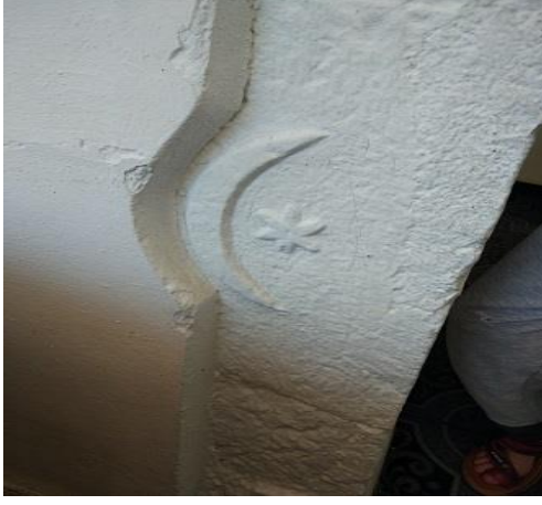
Foto 7: Arifajların Evi, Alt Kat Giriş
