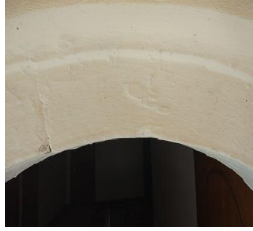
Foto 8: Arifajların Evi, Üst Kat Giriş
