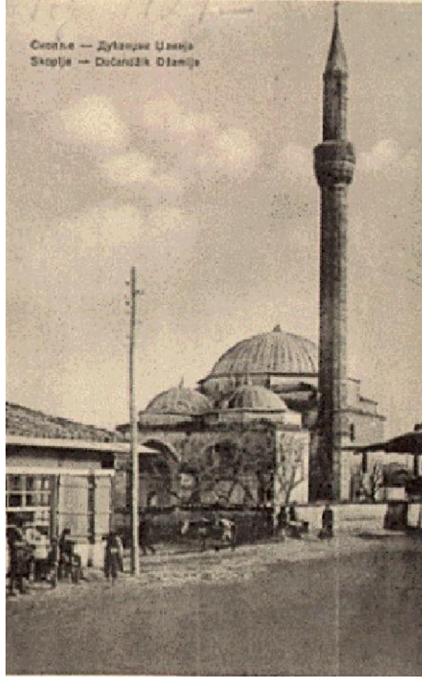
Foto 1. Dükkançık Camii Eski Görünümü (Makedonya Koruma Kurul Arşivi)
