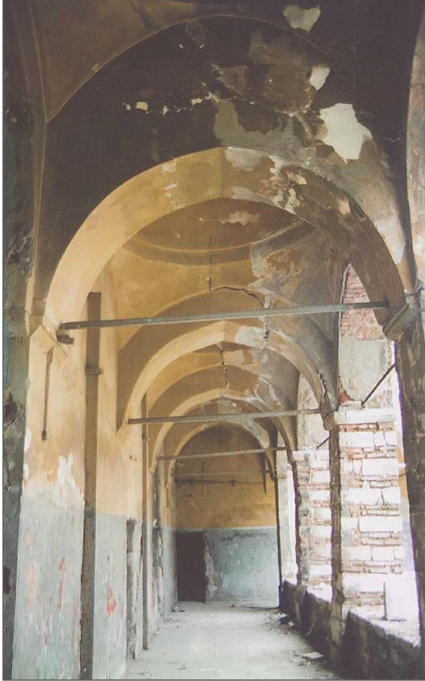
■ “Jet-Grout” uygulaması sonucu; Akdeniz Medreseleri, Ayak Kurşunlu avlu revak kemerleri (Yazarların arşivinden)
