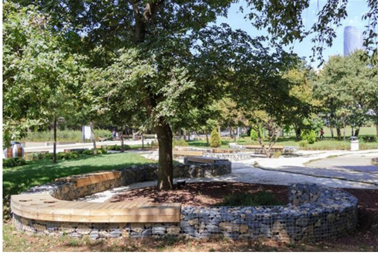
Şekil 6. İTÜ Ayazağa Kampüsü gabion bank uygulaması (itüyeşilkampüs, 2024).
