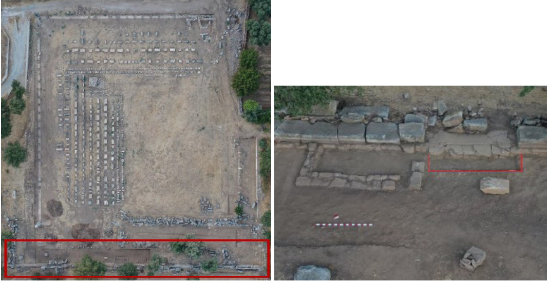
Res. 1: Agoranın havadan çekilmiş fotoğrafı üzerinde güney stoanın konumu ve eşik taşı
