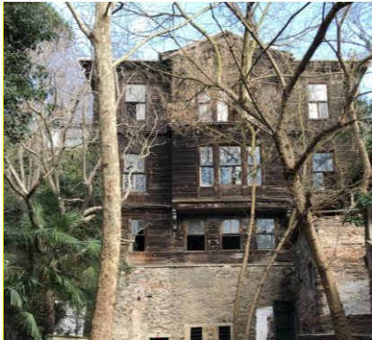
Resim 1. Örnek saha araştırması yapılan İstanbul Bebek'teki ahşap köşkün güney cephesi
