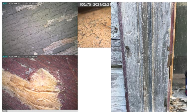
Resim 2. Pencere silmesinde ve ahşap cephede tespit edilen beziryağlı boyalı yüzeyler ve bu yüzeylerin dijital mikroskop altındaki görüntüsü.
