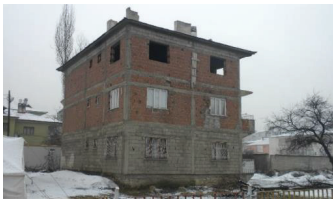
Şekil 1.2011 Van Depremleri'ni hasarsız atlatan 3 katlı kuşatılmış yığma bir yapı, Van Merkez
