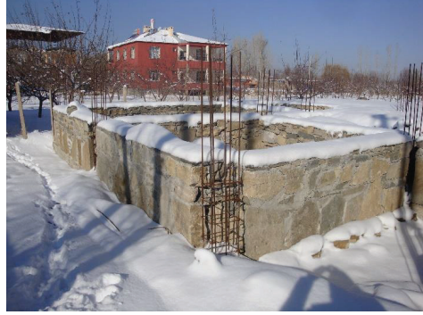
Şekil 2. Van Merkez'de inşaat halindeki kuşatılmış yığma yapı temeli
