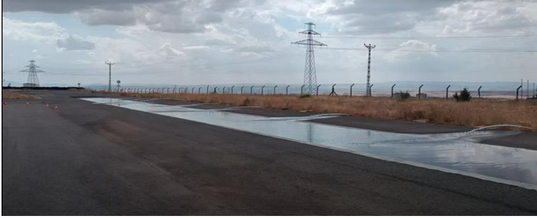
Şekil 4. Petlas Kırşehir Lastik Test Pisti Aquaplaning Test Bölümü (Petlas Kırşehir Tire Test Track Aquaplaning Test Section)
