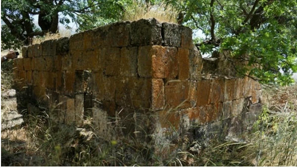
Görsel 24: Kanireş Türbesi kapı açıklığı
