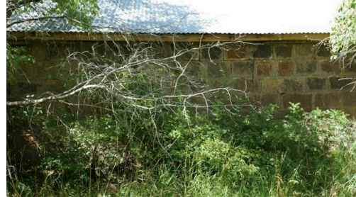
Görsel 14: Güney cepheden görünüş
