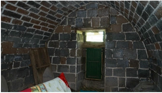
Görsel 16: Mışkan Türbesi giriş kapısı
