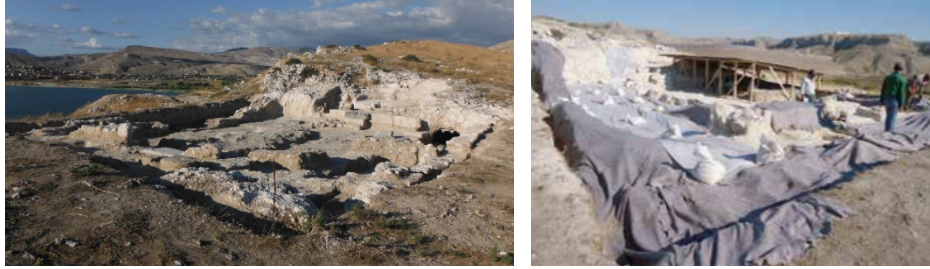
Resim 9. Iuliopolis, 1. No.'lu Bizans Kilisesi, Temizlik Sonrası Üzerinin Layer ve Geotex ile Kapatılması (Sağır, v.d., 2015: 166, Res. 6)
