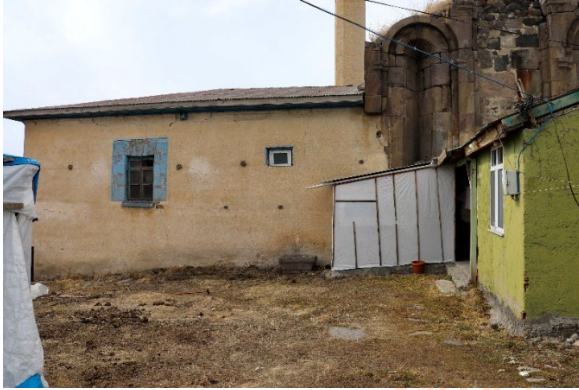
Görsel 6: Doğruyol Köyü Camii Doğu Cephesi (Yeşim Dalkılıç, 2024)
