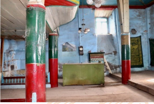
Görsel 15: Doğruyol Köyü Camii Harim Mekanı Doğu Duvarı (Yeşim Dalkılıç, 2024)
