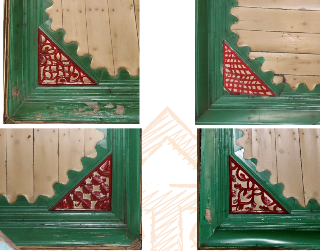
Görsel 18 (a,b,c,d): Doğruyol Köyü Camii Tavanı Süslemelerinden Detay (Yeşim Dalkılıç, 2024)
