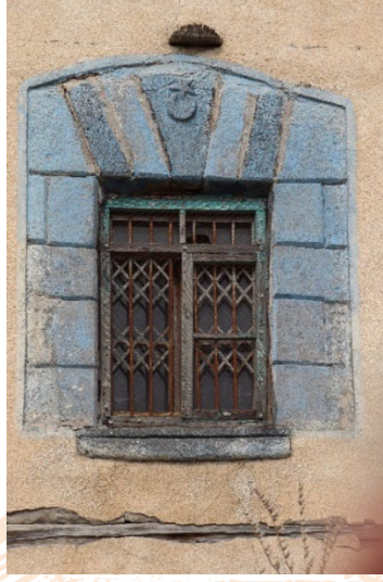
Görsel 8: Doğruyol Köyü Camii Penceresi (Yeşim Dalkılıç, 2024)
