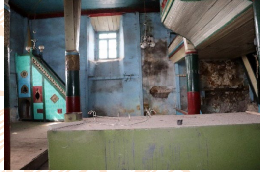
Görsel 16: Doğruyol Köyü Camii Harim Mekanı Batı Duvarı (Yeşim Dalkılıç, 2024)
