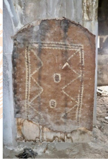
Görsel 13: Doğruyol Köyü Camii Harime Giriş Kapısı (Keçe ile Kaplı Olan İkinci Kapı) (Yeşim Dalkılıç, 2024)
