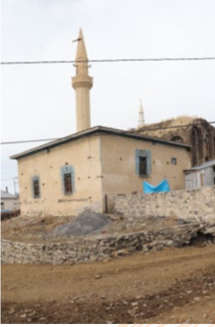
Görsel 4: Doğruyol Köyü Camii Güney ve Doğu Cephesi (Yeşim Dalkılıç, 2024)
