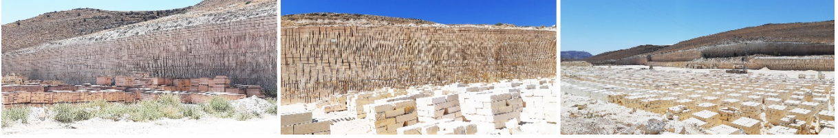
Şekil 1. Böltaş Taş Ocağı, Avanos, Nevşehir. Fotoğraf: Betül Aytepe Serinsu
