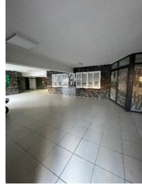
Şekil 6. Yapının bodrum katı
