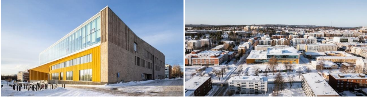
Şekil 3. Lumit Sanat Okulu Cephe Görünüşleri (Pintos, 2023)
