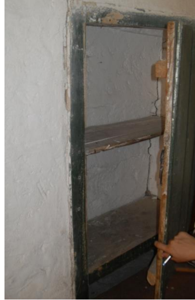
Resim 73. Çavuşin Köyü Ada ? Parsel 1977'deki Konutun Duvar İçi Yüklüğü (Toruk, 2010)
