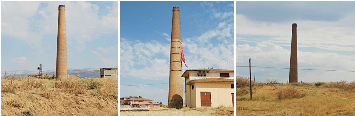
Şekil 1. Yalvaç ilçesinde kültür envanterine kayıtlı olan, Kaş Aşağı Mahallesi'ndeki Baca I (solda) ve Baca II (ortada) ve Abacılar Mahallesi'ndeki Baca III isimli eski tuğla-kiremit fabrikası bacalarından görünüm [9,10,11]
